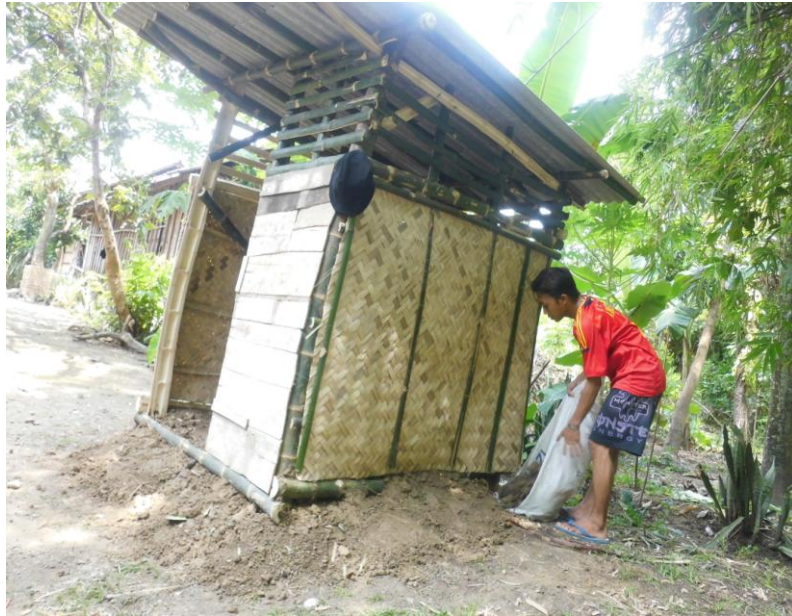
Foto 17. Saat meletakkan tanah disekitar WC
