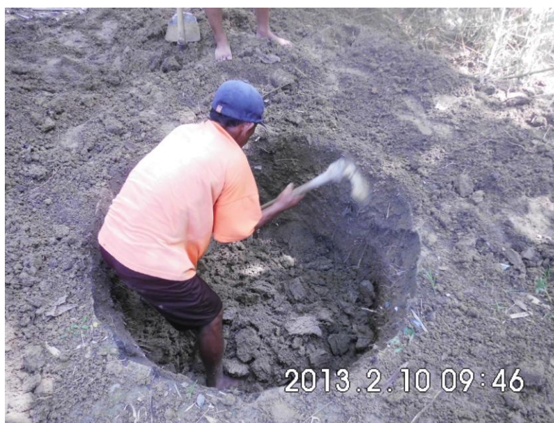
Foto 13. Penggalian lubang septictank yang dilakukan oleh warga
